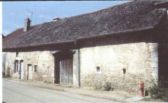
Cette toiture est bien conservée et entretenue. Il ne manque plus qu'un enduit à la chaux aérienne pour que la façade retrouve toute sa jeunesse (Fréville).
