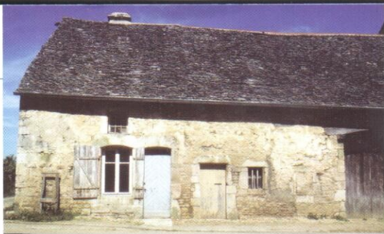
Cette toiture est bien conservée et entretenue. Il ne manque plus qu'un enduit à la chaux aérienne pour que la façade retrouve toute sa jeunesse (Fréville).
