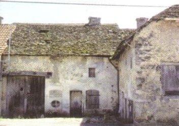
La maison de manouvrier ne compte que deux travées : un grange-écurie, et un logis (Pargny-sur-Mureau).
